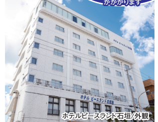
ホテルピースランド石垣/外観
